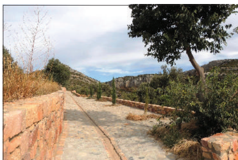
Tramo de paseo empedrado. Por debajo del mismo va la tubería de agua de abastecimiento de la población de Alquézar.
