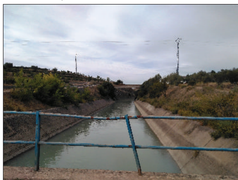
Pasarela sobre el Canal de riego de Aragón y Cataluña.
