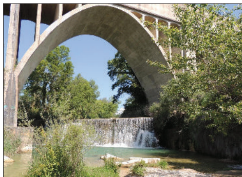
Acueducto del Canal del Cinca que cruza el río Vero.
